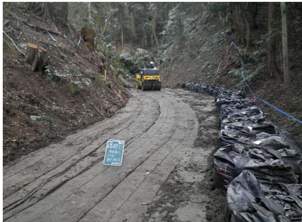
工事中用道路施工状況
