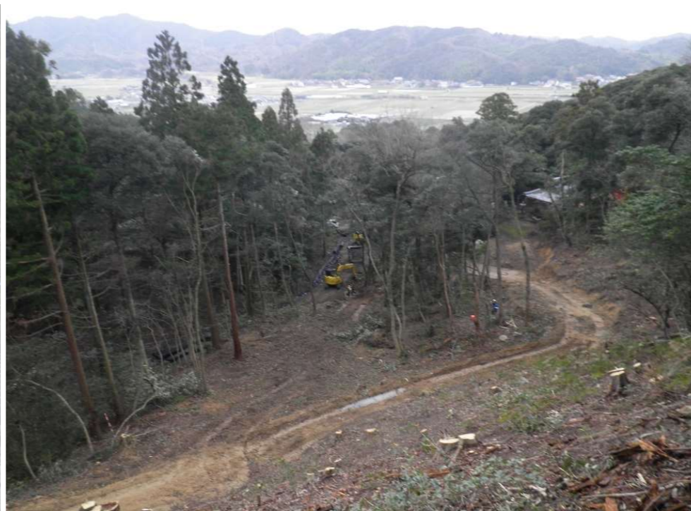
伐採完了(堰堤部より集落側を望む)
