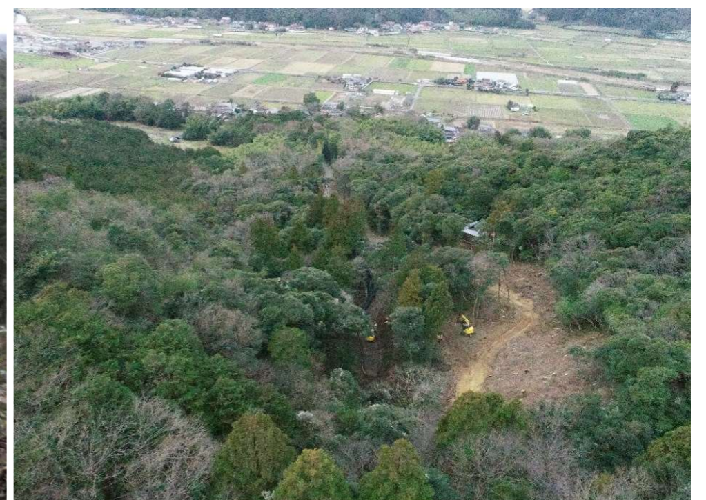
ドローン写真(堰堤上流部より集落側を望む)
