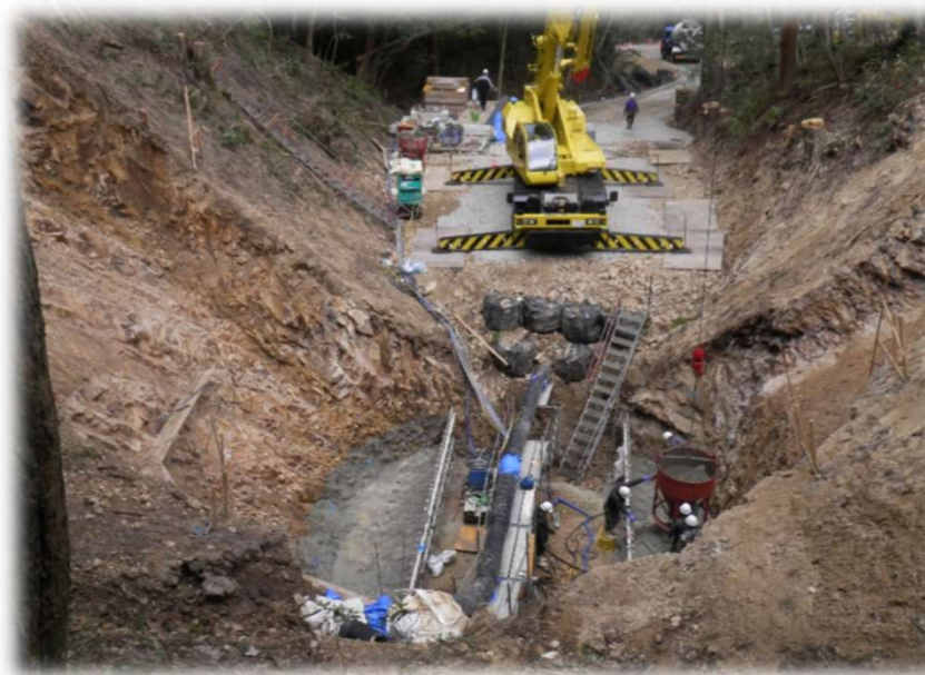
1回目のクレーン打設状況です。4/14
