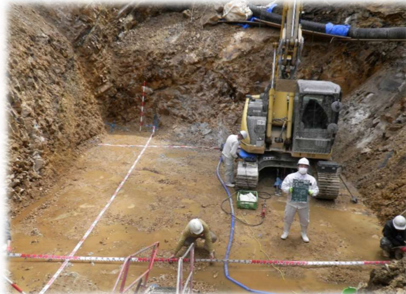
ダムの底(床面)の地盤確認をしています。4/8
