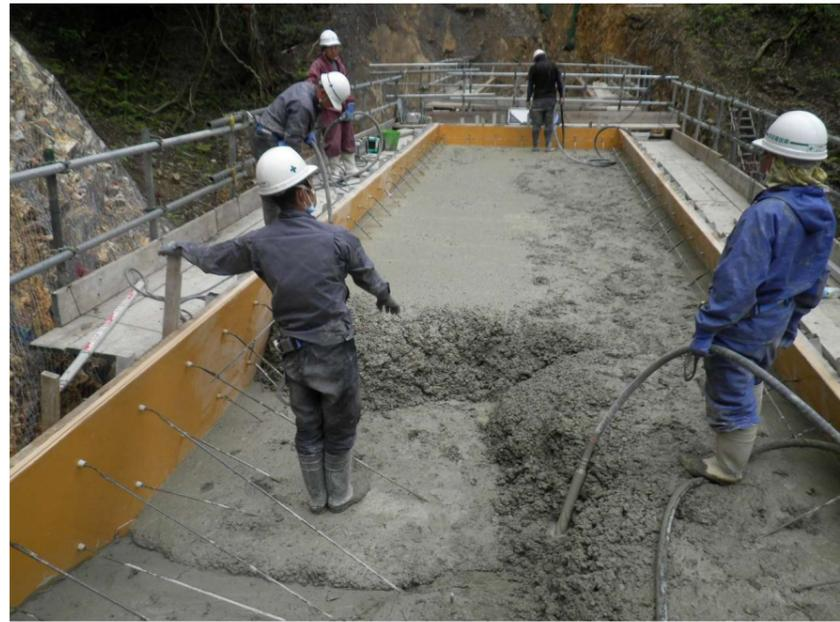
コンクリートの締固め作業をしているところです。
