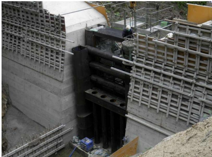
ダム中央部に鋼製スリットを組立てしています。
